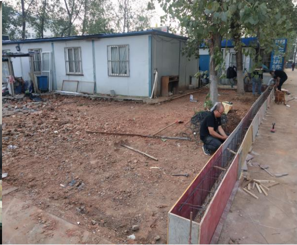
垃圾场改造现场
