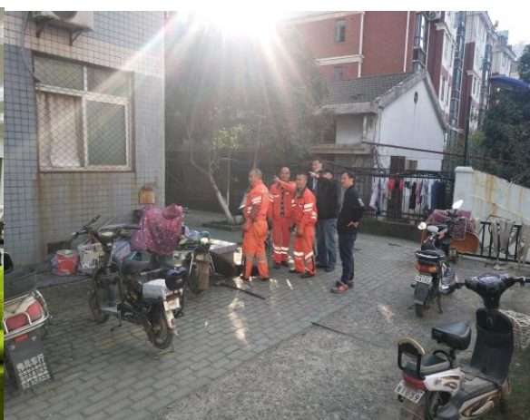
清理下水管道
