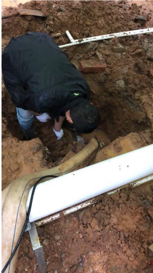
抢修供水管道
