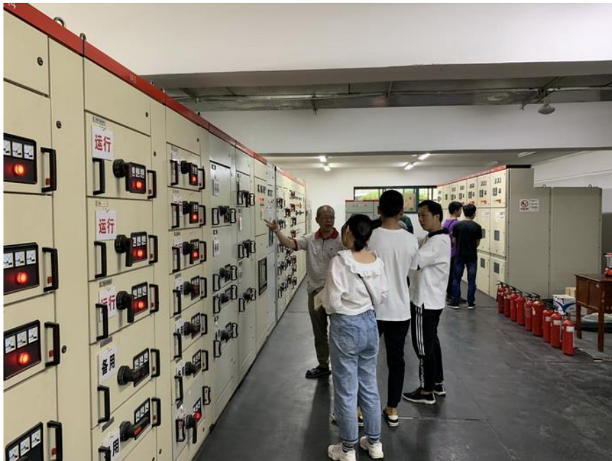
学生参观配电室
